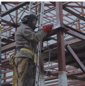
Строительство, монтаж металлоконструкции
