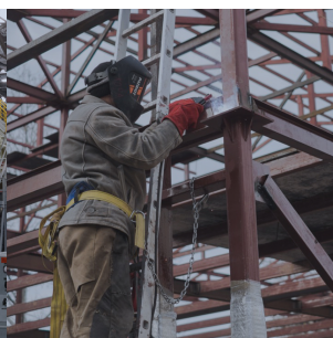
Строительство, монтаж металлоконструкции
