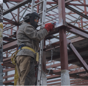
Строительство, монтаж металлоконструкции
